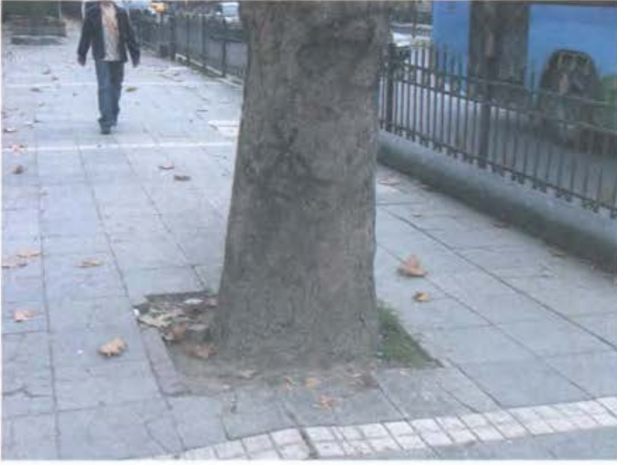
Resim 11. Ağaçlar kök boğumuna kadar sert yapı ile kapatılmıştır.
