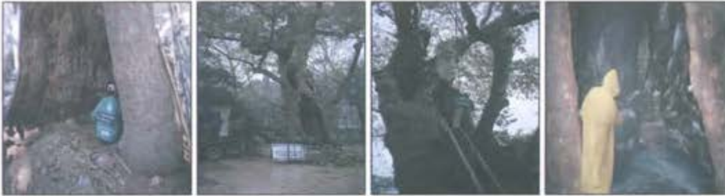
Şekil 19. Eyüp Camii Ve Çevresi Ağaç Restorasyon Çalışmaları Aşamaları
