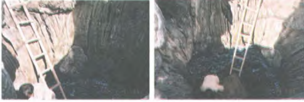
Şekil 11.Gövdenin Toprak Altı Bölümünde Yapılan Temizleme ve İyileştirme Çalışmaları
