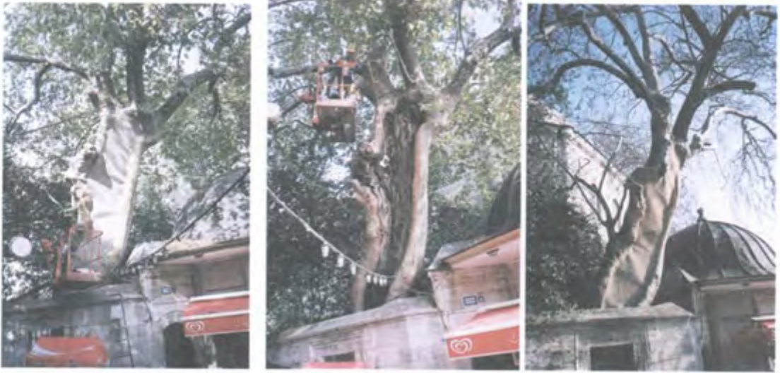
Şekil 24. Ayasofya Müzesi Ağaç Restorasyon Çalışmaları
