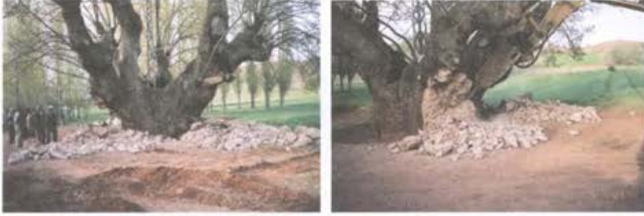
Şekil 8. Ağacın Gövde Çevresindeki Betonların Kırılması
