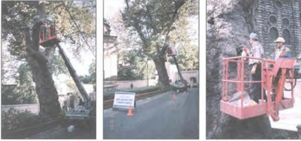
Şekil 31. Eminönü Alemdar Caddesi (Gülhane Parkı Önü) Ağaç Restorasyon Çalışması
