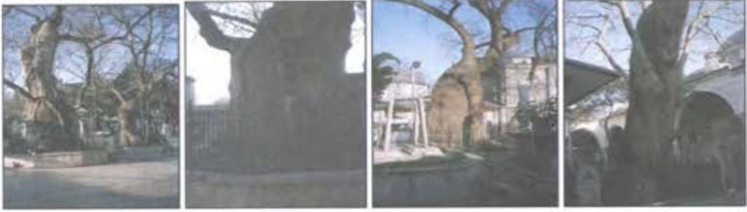
Şekil 20. Eyüp Camii ve Çevresi Ağaç Restorasyon Çalışmaları Sonucu Görünümler
