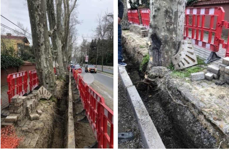
Resim 2. Valide Sultan Caddesi'nde elektrik kablosu yenileme çalışmaları nedeniyle ağaç kök yayılış alanında açılan kanal.
